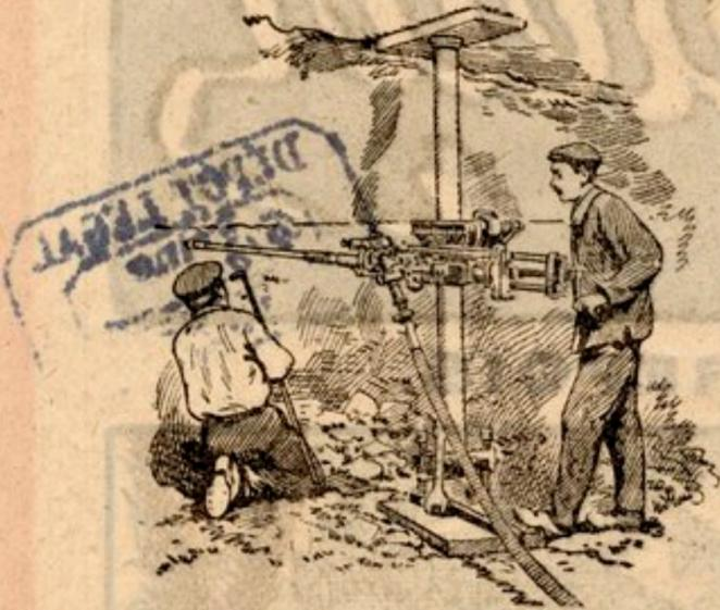
FIG. 1. — Perforatrice pneumatique.
